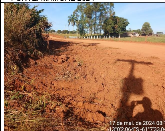
FIGURA 04 – Atividades de pavimentação sendo realizadas – FONTE: MAMORÉ 2024
