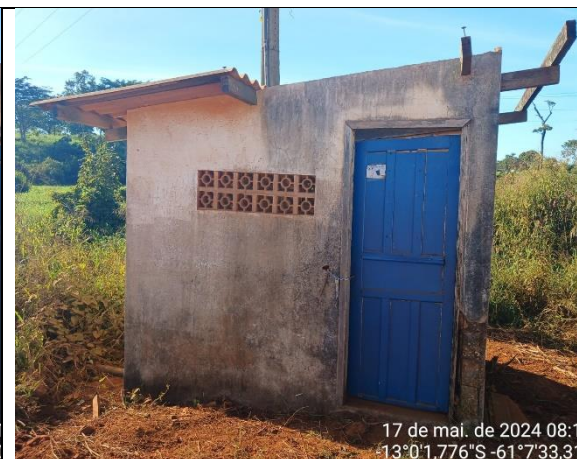
FIGURA 02 – Edificação (casa de máquinas) – FONTE: MAMORÉ 2024
