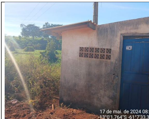
FIGURA 01 – Edificação (casa de máquinas) – FONTE: MAMORÉ 2024
